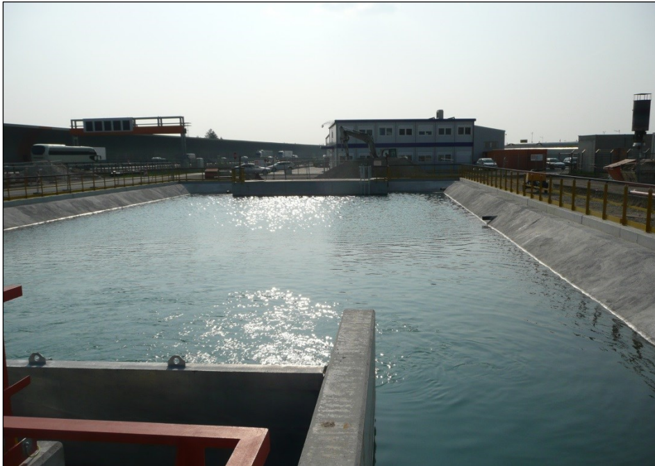
Abbildung 49: Polymerabscheibe becken am Betriebsgelände der Borealis. © Borealis
