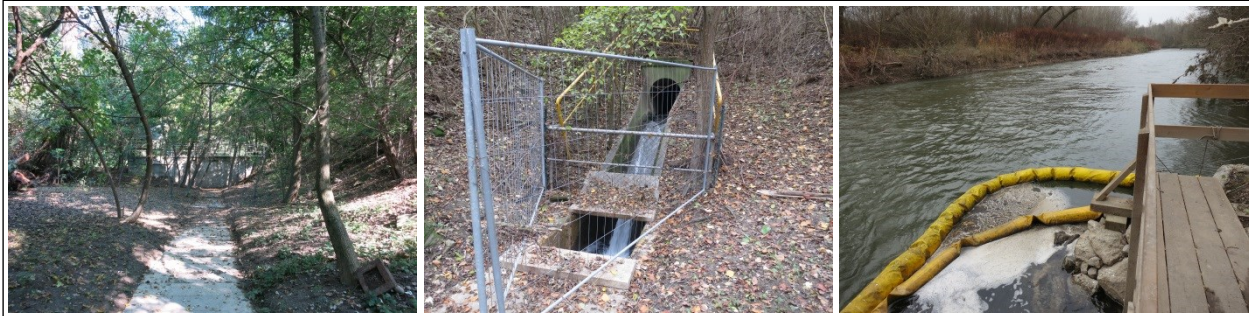
Abbildung 12: Fa. Borealis – links: überdecktes Betongerinne, Mulde und Messwehr; Mitte: Mündung Reinwasser-Kanal in Schussrinne; rechts: Einmündung in die Schwechat. © IHW/BOKU
