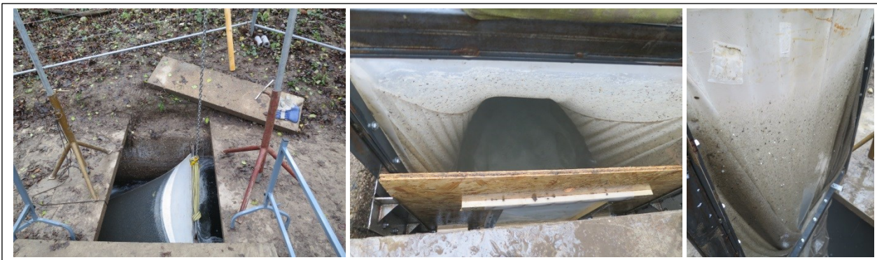
Abbildung 14: Fa. Borealis – links: Messgerät im Ablaufgerinne; Mitte: Schützentafel zur Filterung des Rückstromes beim Heben; rechts: Filtrat am soeben geborgenen Messgerät. © IWHW/BOKU
