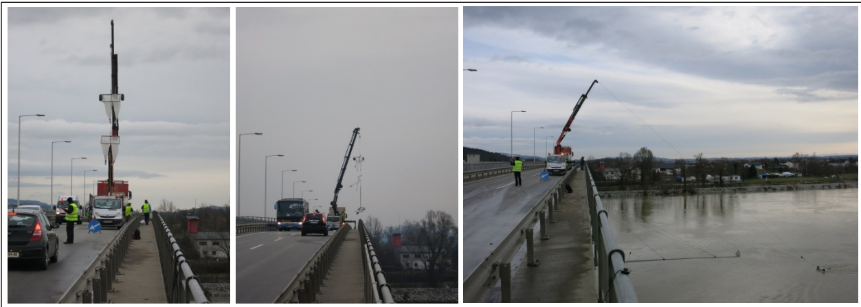
Abbildung 4: Messgerät wird mit Hilfe eines Lkw in die Donau abgesenkt. © IWHW/BOKU
