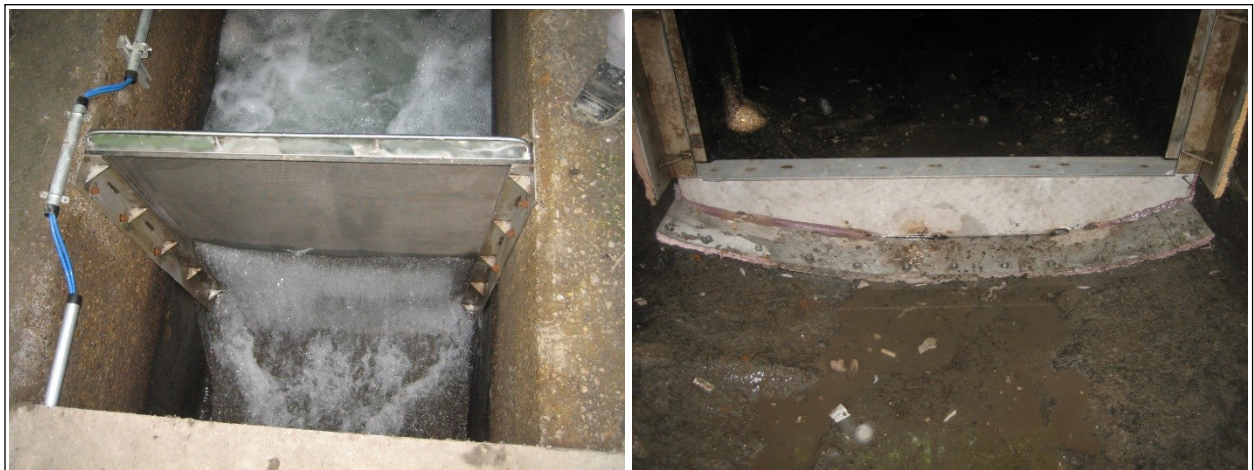
Abbildung 50: Funktion des Stecksiebs am Ablauf des Reinwasserkanals der Borealis und Bodenabschluss des Stecksiebs/Lochblechs am Betonrechteckgerinne nach erfolgter Reparatur. © Borealis.
